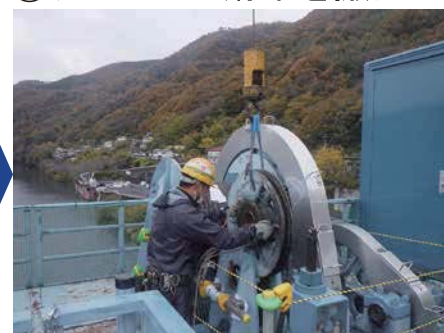
②クレーンで滑車を搬出
